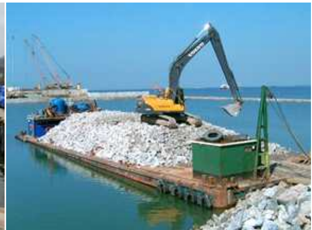
그림 3 건설공사용 바지(Barge)선
