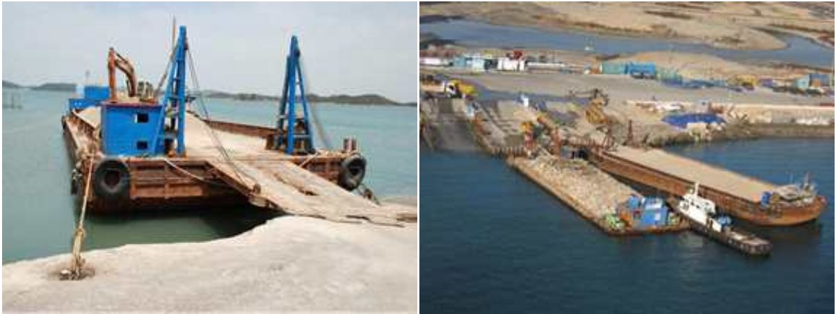
그림 4 물양장 바지(Barge)선 고정 및 접안시설
